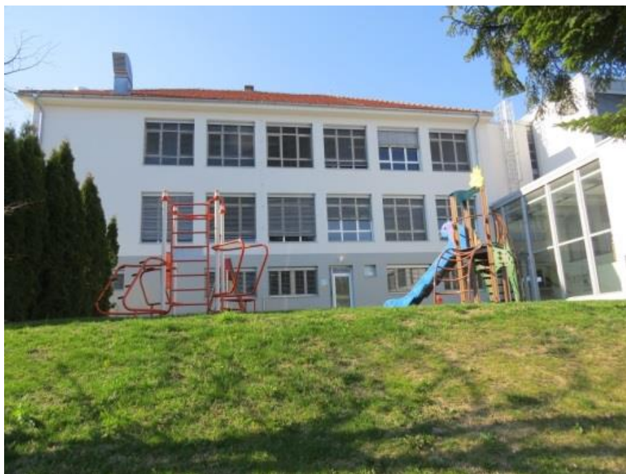
Obnovljena vzhodna stran šolskega poslopja z novimi igrali
